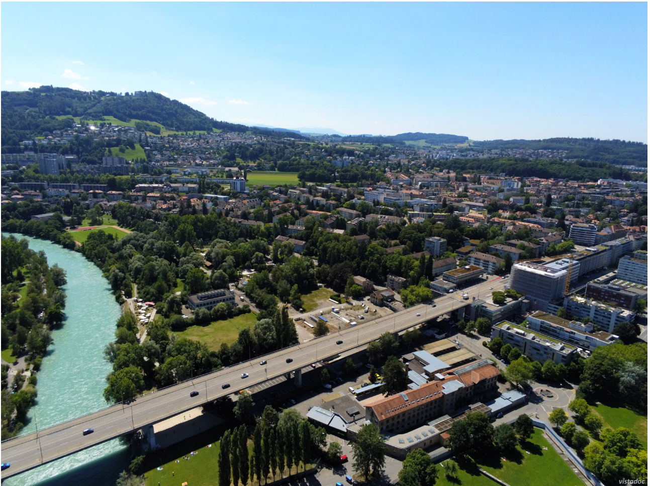
Drohnenbild – Blick in Richtung Südwesten
